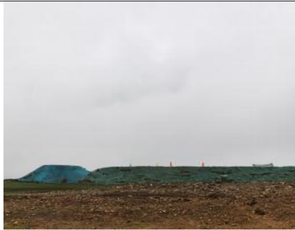
弃土覆盖 环保措施落实情况
